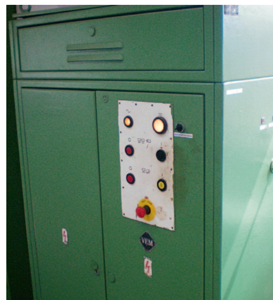
An diesem Steuerungsschrank für eine Werkzeugmaschine wurde ein Bedientableau nachgerüstet.
